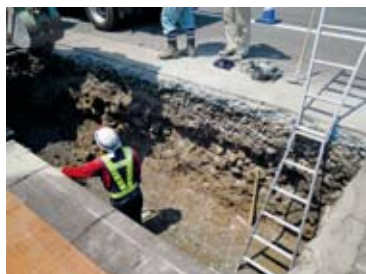
①掘削後敷砂
