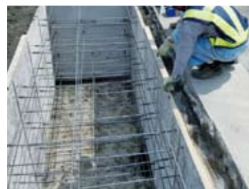
③型枠レベル調整
