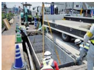
②KCスタンドフォーム据付け
