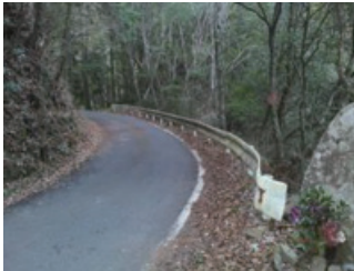
湯島崩野線:施工前
