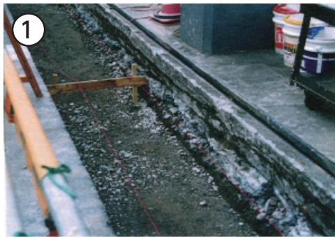
① 基礎砕石 敷設
