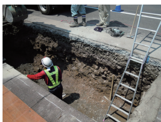
①掘削状況
