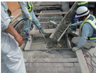
⑤生コン打設
