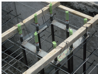
④アンカー筋設置
