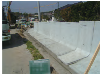
▲L型擁壁の基礎地盤補強の採用事例。農耕地に隣接しているため、コンクリートによる地盤改良が行えず、周囲の環境に影響を与えないジオグリッドを用いた「マットレス工法」が採用になりました。
