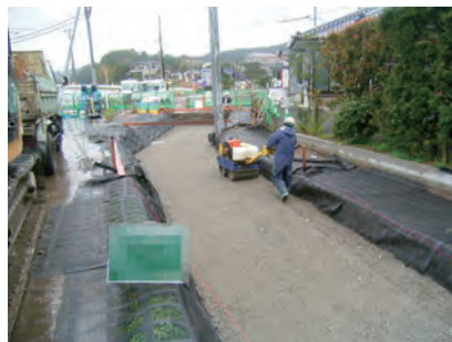
▲L型擁壁の基礎地盤補強の採用事例。農耕地に隣接しているため、コンクリートによる地盤改良が行えず、周囲の環境に影響を与えないジオグリッドを用いた「マットレス工法」が採用になりました。
