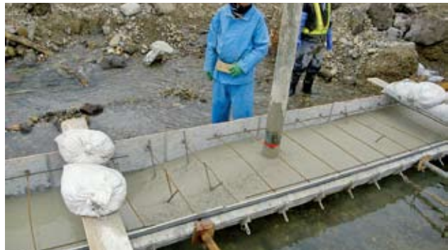
水中コンクリート打設
