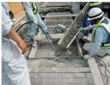
⑤生コン打設。周辺埋戻し。
