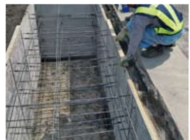
③型枠レベル調整
