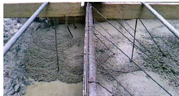
生コンは交互に打設。 生コン圧を打ち消しあい、補強を最低限に抑えます。
