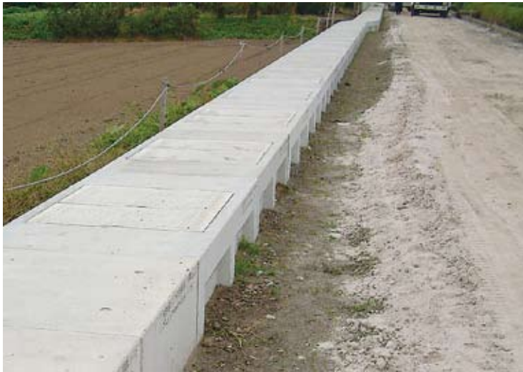
■片土圧による土留工法
