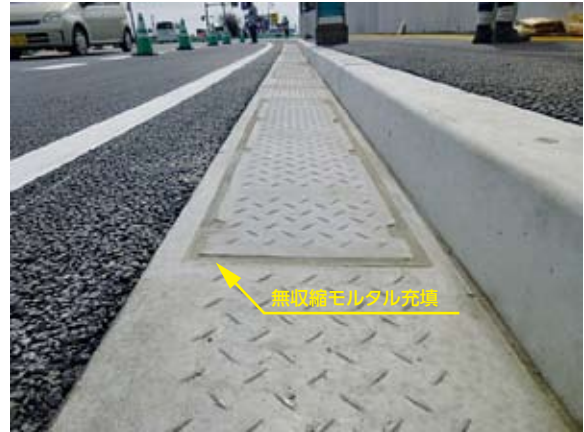
▼熊本市国道3号
