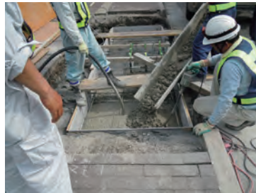
⑤生コン打設。周辺埋戻し。
