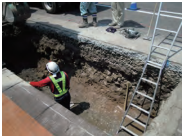
①掘削後敷砂
