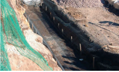
1.かごテンサー基礎敷設
