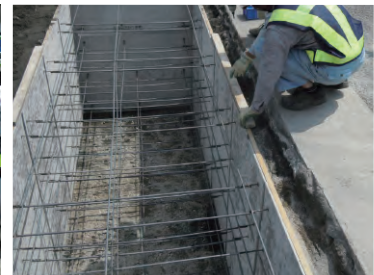
③型枠レベル調整
