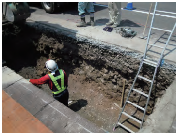
①掘削後敷砂
