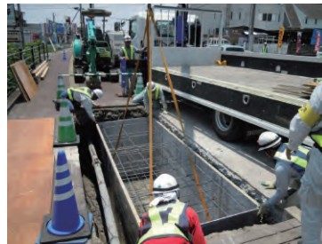
②KCスタンドフォーム据付け
