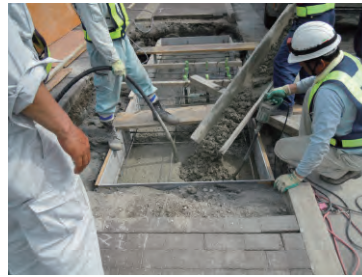
⑤生コン打設。周辺埋戻し。
