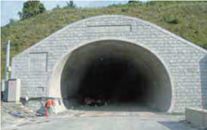
▼トンネル工事
