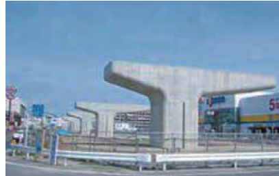
▼高架下部工事
