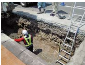
①掘削後敷砂
