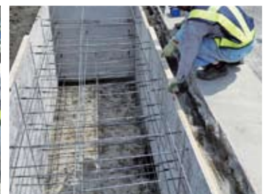
③型枠レベル調整
