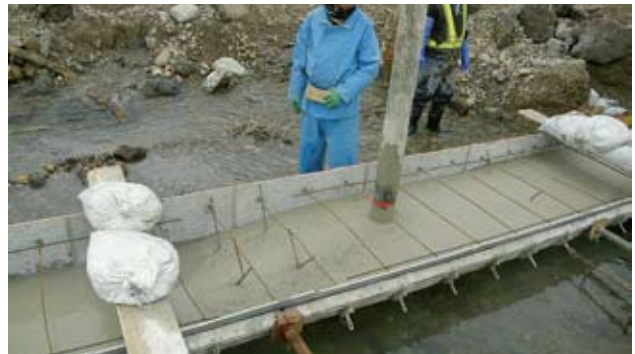
水中コンクリート打設
