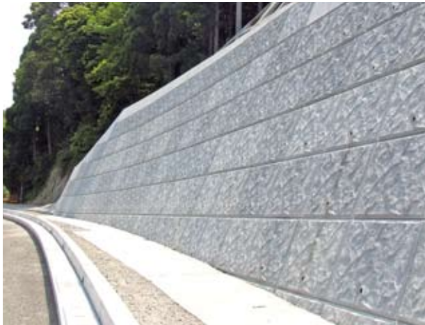
擬岩タイプ(階段積みもたれ式擁壁)
