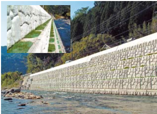
擬岩タイプ(階段積みもたれ式擁壁)
