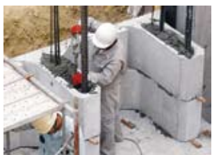
⑤ 縦貫コンクリート打設
