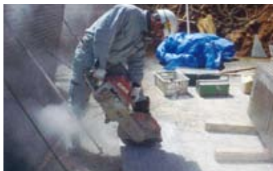
4. 型枠パネル切断加工状況
