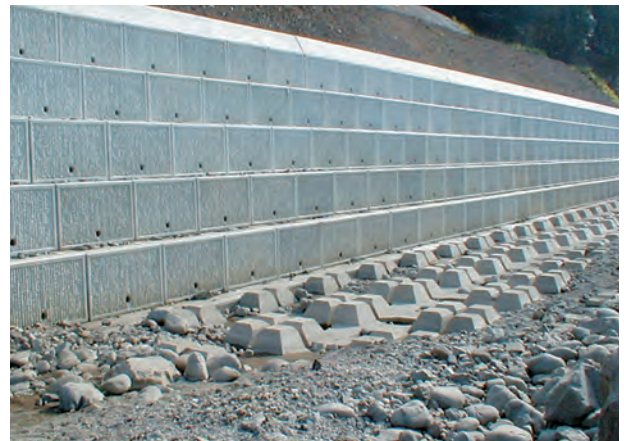
標準ブロック (階段積みもたれ式擁壁)
