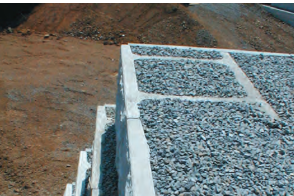
コーナー部の施工
