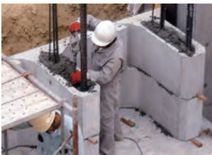
⑤ 縦貫コンクリート打設
