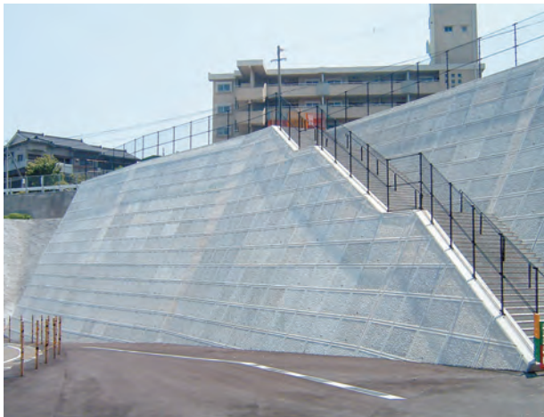
擬岩タイプ (階段積みもたれ式擁壁)
