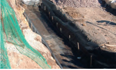
1.かごテンサー基礎敷設
