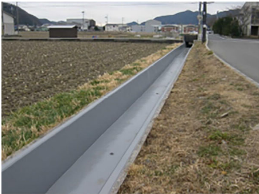
水路補修、農業施設維持管理
