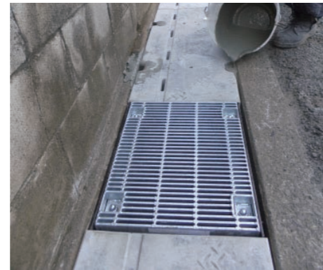
▼無収縮モルタル注入状況 ゲーリッド本体と専用グレーチングは共に両サイドに無収縮モルタルを充填して固定します。
