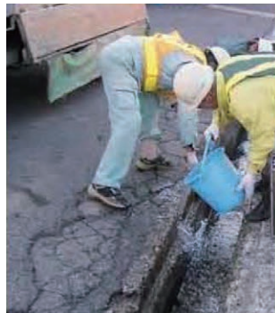
7. 充填剤の練り混ぜと充填
