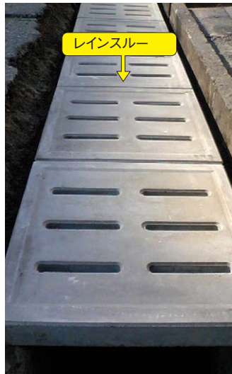
▼施工中(レインスルー敷設)
