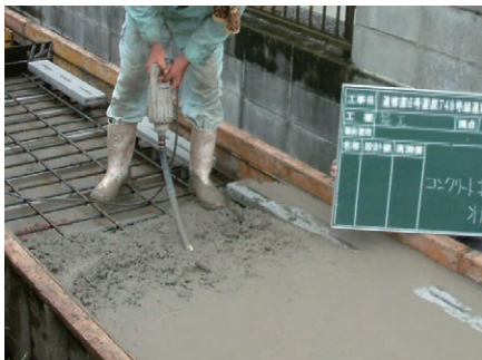
④コンクリート打設
