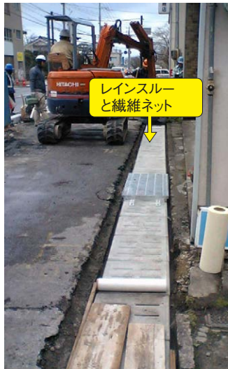
▼施工中(繊維ネット敷設)
