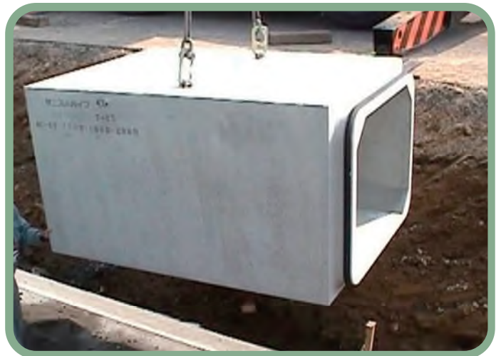
施主：可見市 工事名：中恵土雨水幹線 サイズ：1200×1000(幅×高さ)
