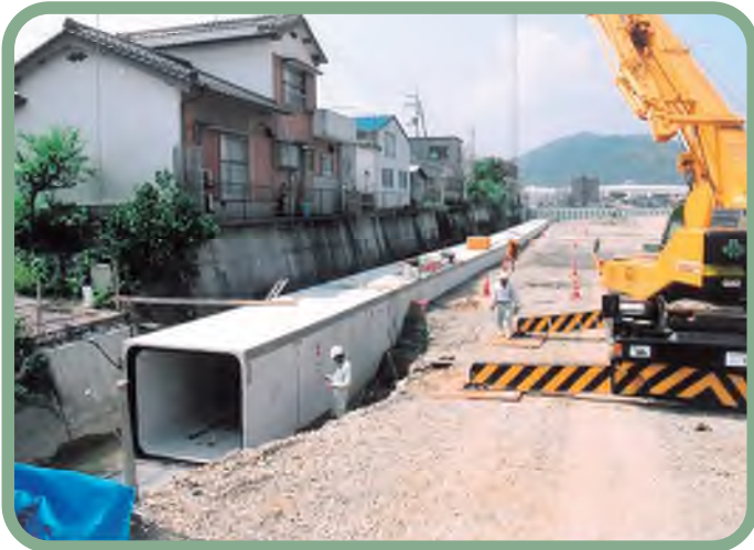
施主：須崎市役所 工事名：神田雨水管渠築造(その2)工事 サイズ：2000×1800(幅×高さ)
