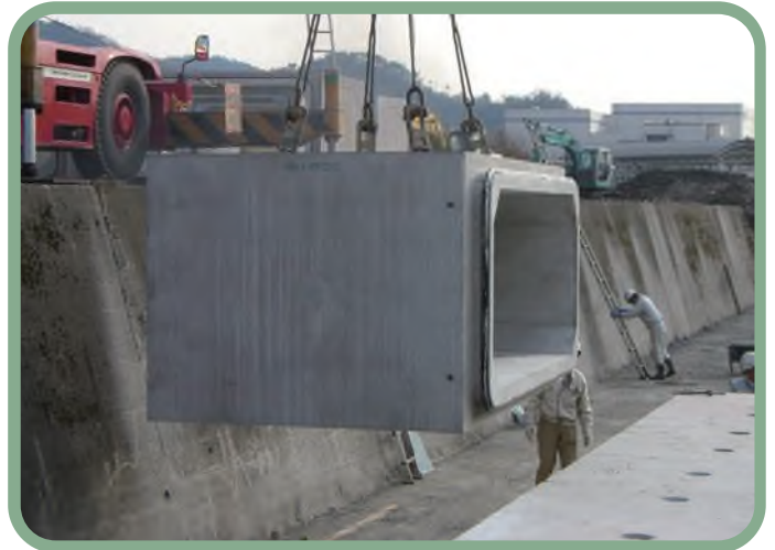
施主：米原市 工事名：米原南第1雨水幹線整備工事 サイズ：3000×1200(幅×高さ)
