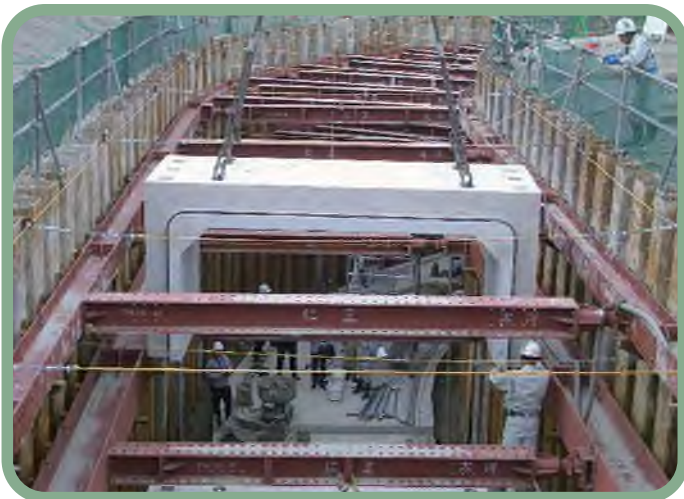
施主：国土交通省浪速国道事務所 工事名：第二京阪(大阪北道路) 讃良地区 下部その他工事 サイズ：3400×3000(幅×高さ)
