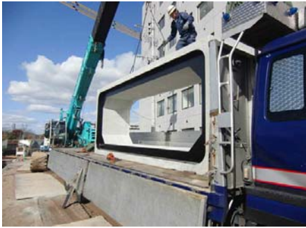
施工写真024. JPG
