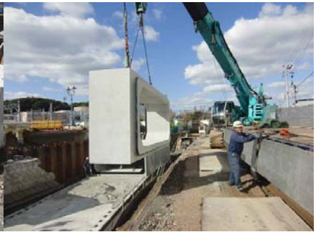
施工写真026. JPG
