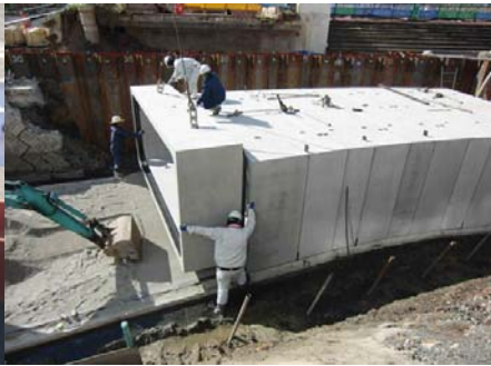
施工写真027. JPG
