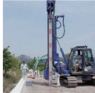
施工手順2: H型PCパイル打設
