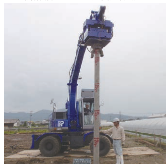
施工機械:油圧パイプロ超高速微動マシン
