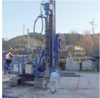
施工手順1: オーガーによる先行掘削
