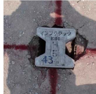
施工手順4: 打設完了
