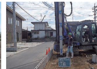
▼戸建住宅施工例
