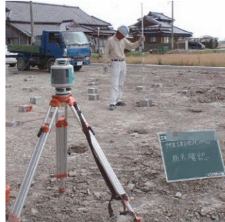
施工手順3: 杭天レベル確認
