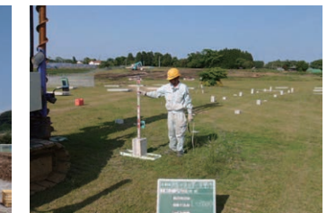
▼ソーラー発電パネル基礎施工例
