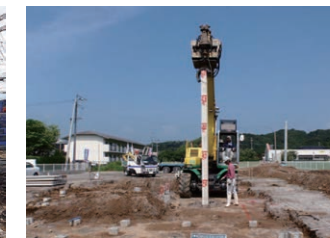
▼集合住宅施工例
