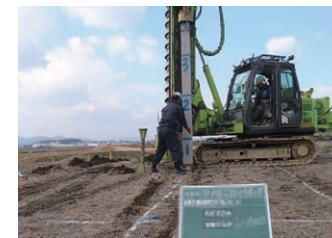
▼戸建住宅施工例
