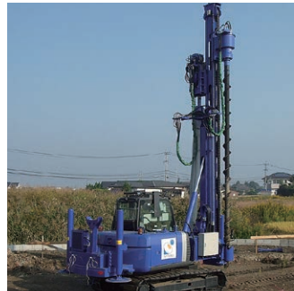
施工機械:リーダー式打設機
