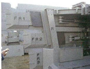
メッセルジャッキ伸ばし状況
