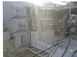
全てのジャッキを縮めると本体がメッセル上を前進します。
