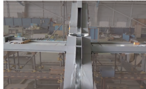
「マスマス整流ます」設置
