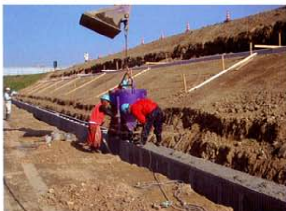
「NKシリーズ打設状況」
