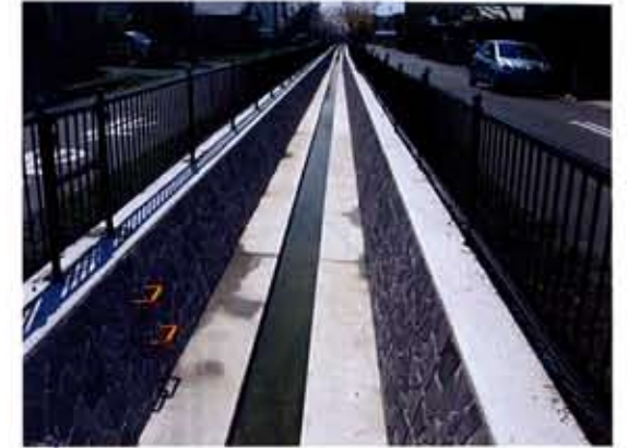
【静岡県】 西部農林事務所 浜名中央地区親水護岸工事 (メーク本石鉄平石張り)
