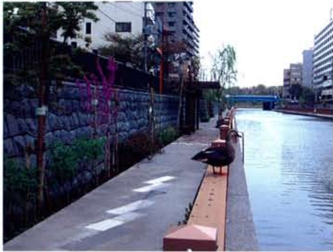
【東京都】 江東治水事務所 小名木川護岸整備工事 (ピアストーン工法) (ピアスタイプ) (自然石シリーズのつら積み(小)タイプ)
