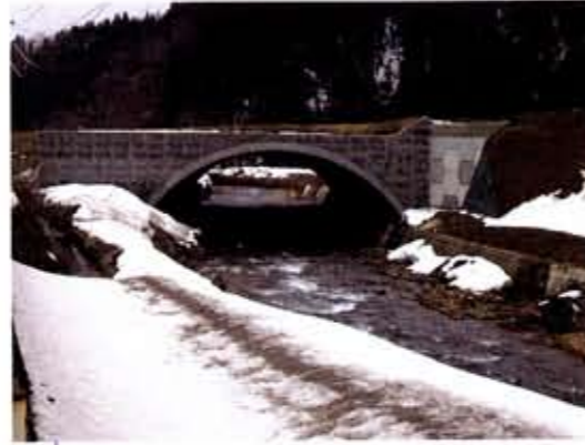
「山形県」 東北地方整備局山形河川国道事務所 前坂道路改良工事 (アーチカルバート) (ワンダータイプ)
