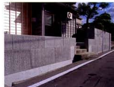
「石川県」 民間 外構工事 (メークハツリ面)
