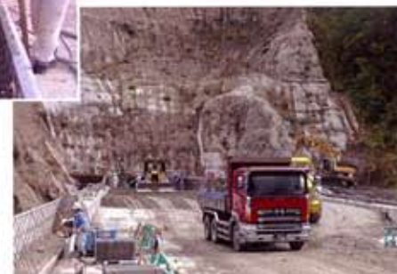
「施工状況全景」
