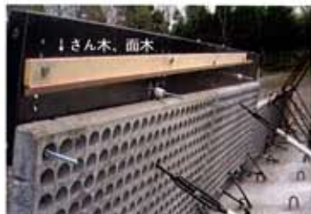
「天端斜め勾配仕上げの取付け例」
