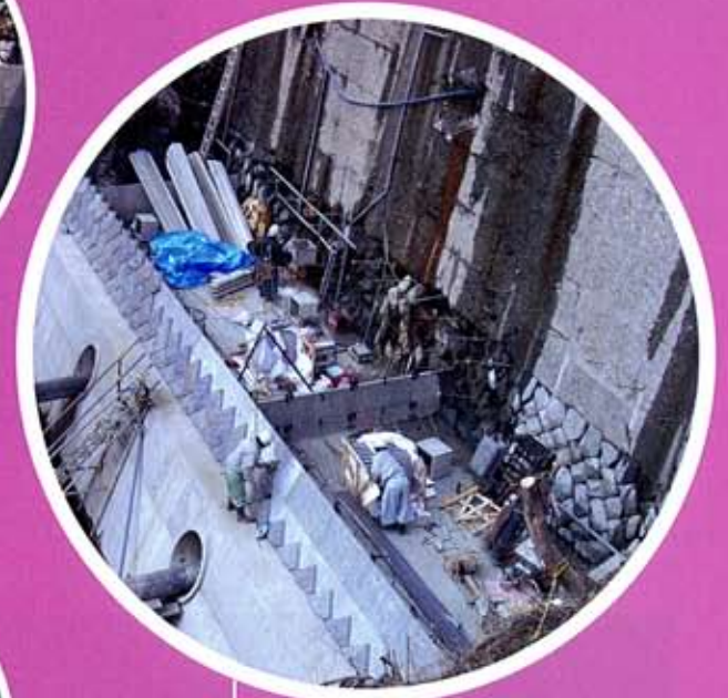
「群馬県」 関東地方整備局澁良瀬川河川事務所 安藤沢砂防環境補強工事(ピアストーン工法) (ピアスタップ)(自然石シリーズ谷積みタイプ)
