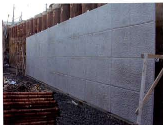
「青森県」 三戸地方漁港漁場整備事務所 八戸地区広域漁港整備工事(鋼管杭修景) (メークハツリ面)
