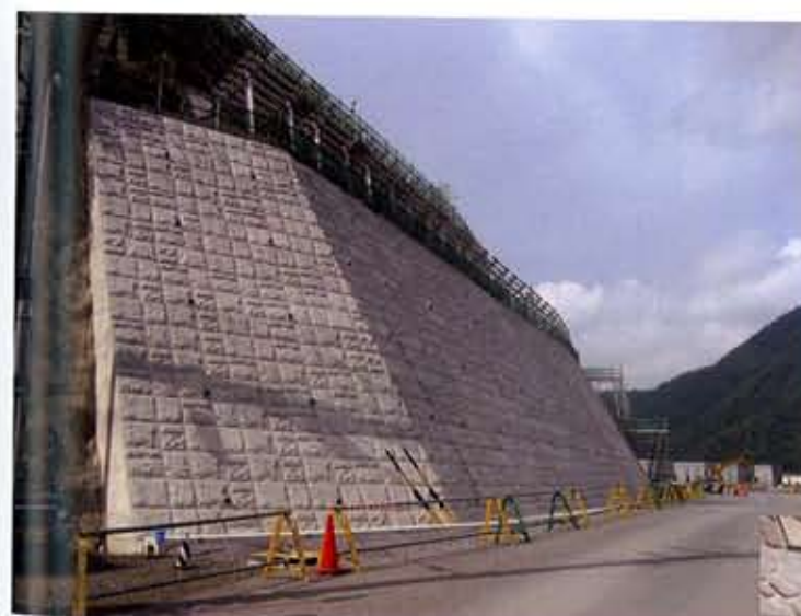
「岐阜県」 水資源機構徳山ダム建設所 ダムサイト右岸法面施設その他工事 (メーク割石40)
