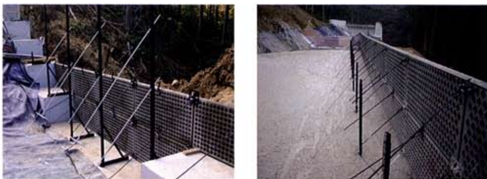
「アンカー式セバ使用状況」
