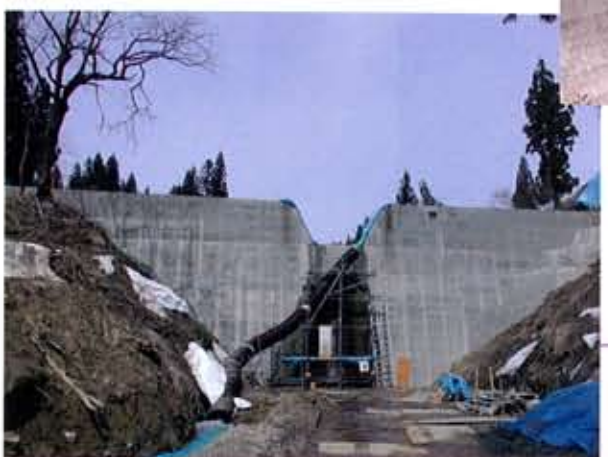
「新潟県」 魚沼地域振興局 災害関連砂防越又川堰堤工事 (ピアスタップ) (ワンダータイプ)
