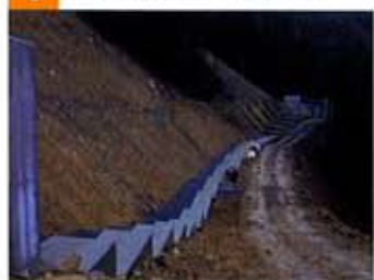
4 組立システムを用いての壁面材設置状況
