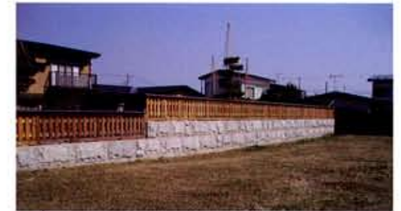
「岩手県」 民間 擁壁工事 (メーク割石60)
