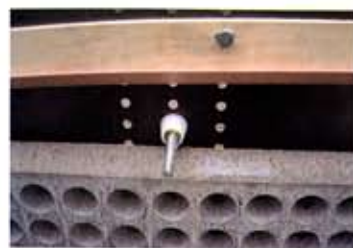
「Pコン取付状況」 （注：セバ鉄筋溶接前の状況）
