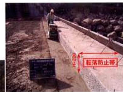
「端部転圧状況」 (転落防止帯による安全作業)
