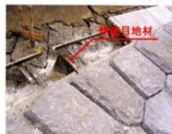
「伸縮目地材が表面に現れない状況」
