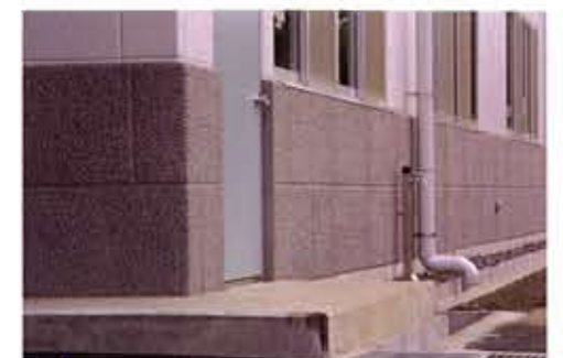
「静岡県」 民間 工場外構工事 (メークハツリ面着色)
