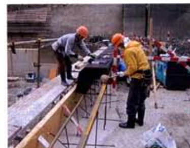
「コーナー部ゴム型枠設置状況」
