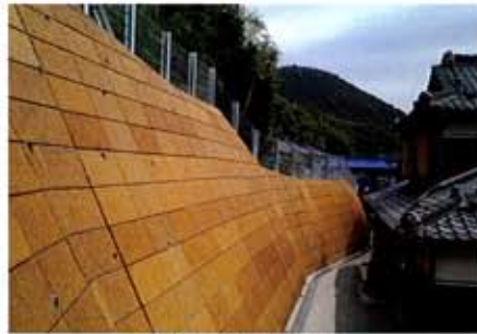
「急傾斜擁壁施工例」
