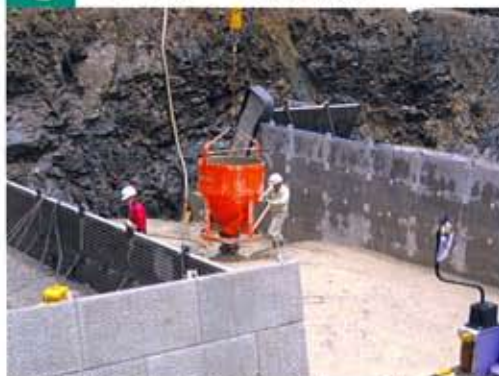
5 コンクリート打設状況
