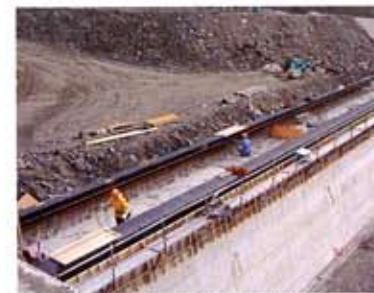
「コーナー部ゴム型枠設置完了状況」
