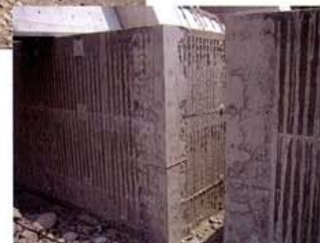
「護床工完成状況」
