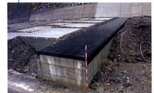
【長野県】 北陸地方整備局松本砂防事務所 葛葉下流第1帯工事 (ゴム型枠)
