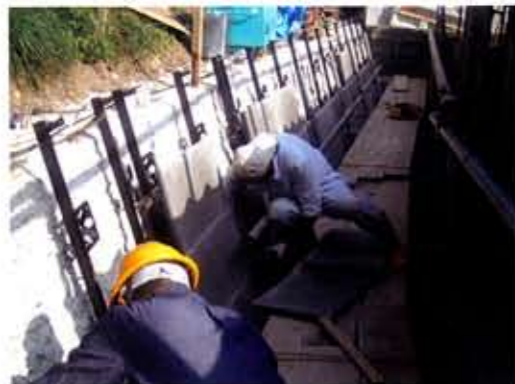
「石川県」 中能登農林総合事務所 地滑り対策事業七尾東部地区 (ワンダータイプミニサイズ) (ワンダーユニットシステム)
