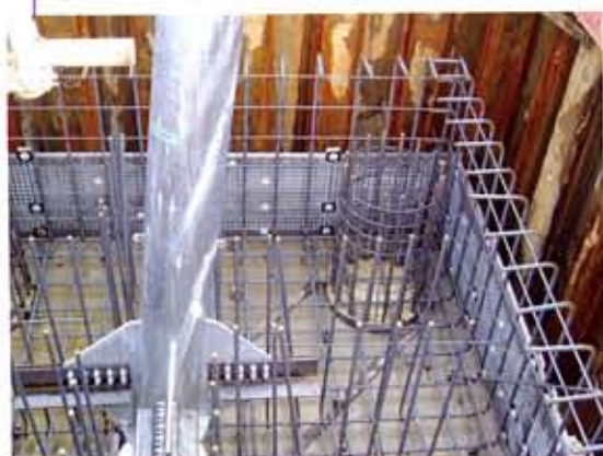
「新潟県」 中部電力株式会社 上越火力線新設工事(送電線基礎) (ピアスタ입)
