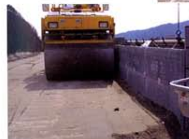
「振動ローラー転圧状況」
