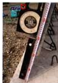
「取付状況（側面）」
