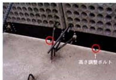
「内部セバ鉄筋溶接状況」
