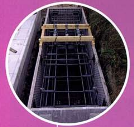
「青森県」 東北地方整備局青森河川国道事務所 浪岡地区構造物設置工事(標識基礎) (ピアスタップ、事前組立)
