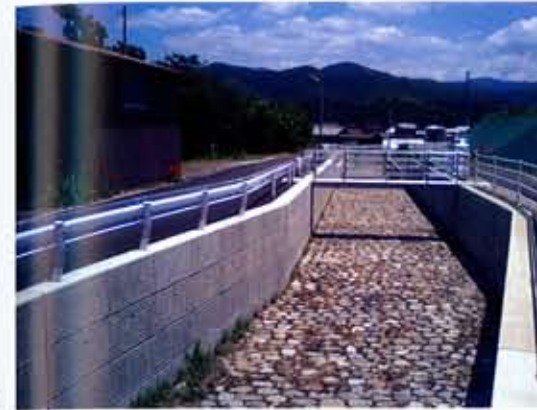
【高知県】 安芸土木事務所 岩谷川荒廃砂防工事 (メークハツリ面)
