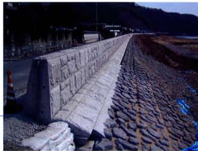
【山口県】 岩国土木建築事務所 錦川河川激甚災害対策特別緊急工事 (メーク割石40)
