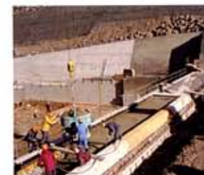
「コンクリート打設状況」
