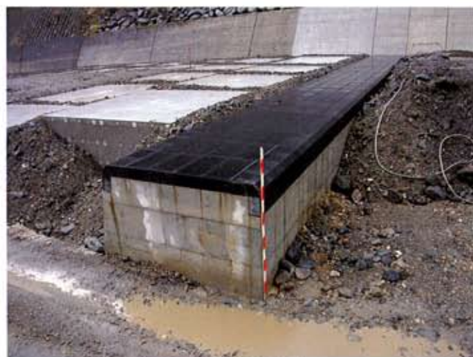
「右岸施工完了状況」
