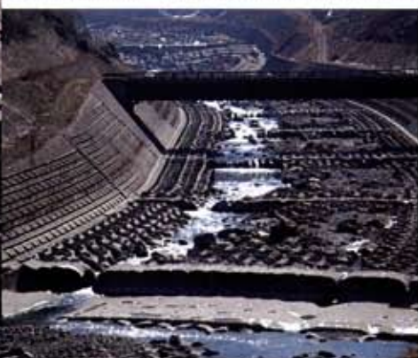
「現場付近の状況」
