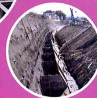
「静岡県」 中部地方整備局沼津河川国道事務所 狩野川牧之郷護岸災害復旧工事 (ピアスタップ)(メーク本石ごろた石張り)
