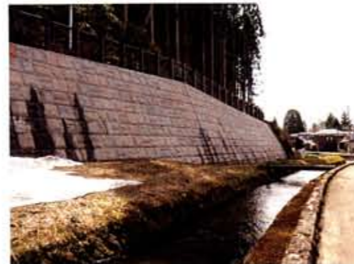
「山形県」 最上総合支庁 上河原擁壁工事 (メーク割石40着色)
