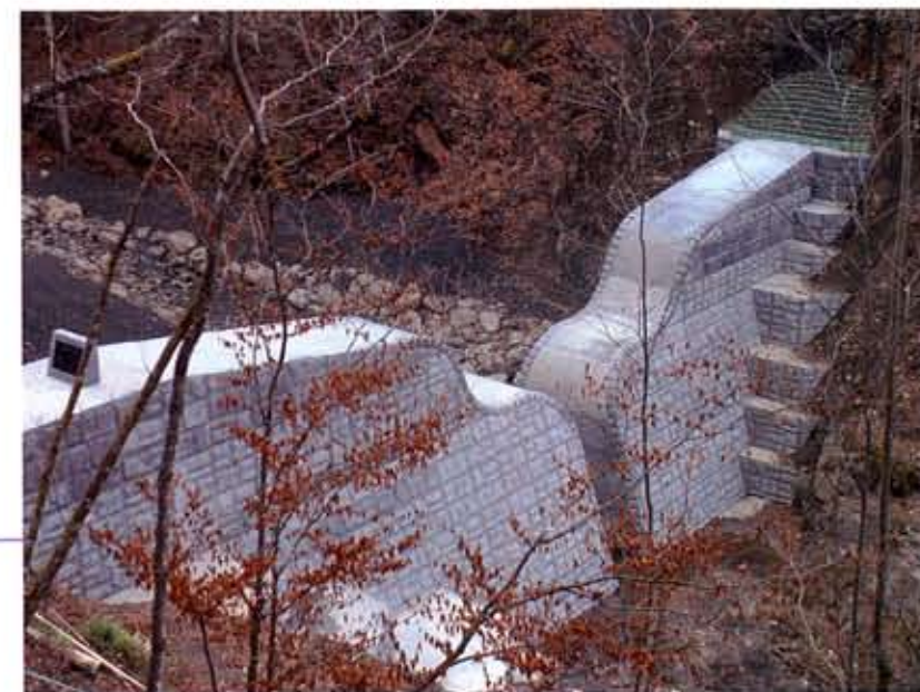
「群馬県」 関東地方整備局利根川水系砂防事務所 御巢産第3砂防堰堤工事 (ピアスタップ) (メーク割石40着色)
