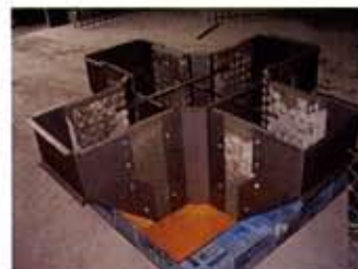
「ピアスとの取付状況」
