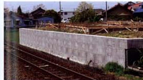
「愛知県」 民間 宅地造成工事 (ワンダーフラットタイプ)
