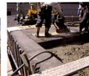
「天端部ゴム型枠設置状況」
