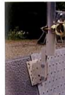
「施工途中の取付例」
