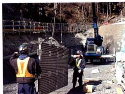
「埼玉県」 水資源機構荒川ダム総合事業所 滝沢ダム入波沢水路工事 (ピアスタ입、事前組立)
