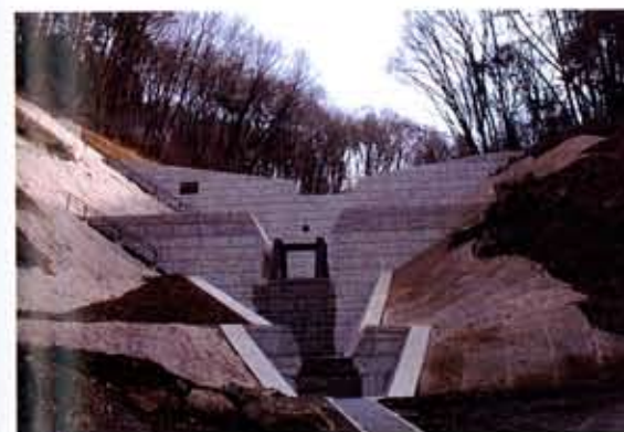
「長野県」 諏訪建設事務所 災害関連緊急砂防工事厚沢川 (ピラストタイプ)(メークハツリ面)(メーク割石40)
