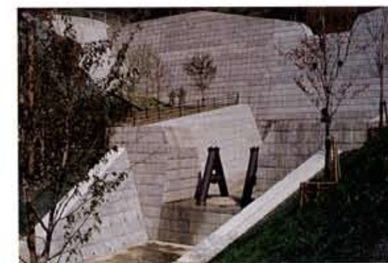
「佐賀県」 神崎土木事務所 広滝西川通常砂防工事 (ピラストタイプ)(メーク割石40)
