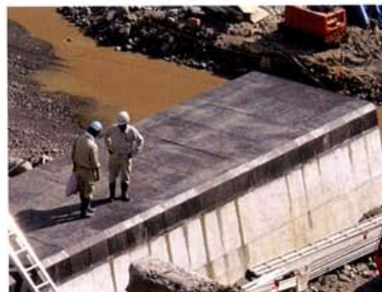
「完成（右岸施工完了状況）」
