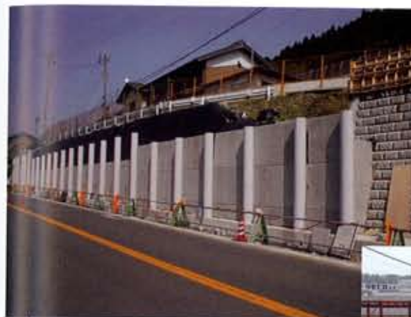
「滋賀県」 近畿地方整備局滋賀国道事務所 21号米原地区構造物補修工事 (FCB工法) (メークハツリ面) (メークハンガーシステム)
