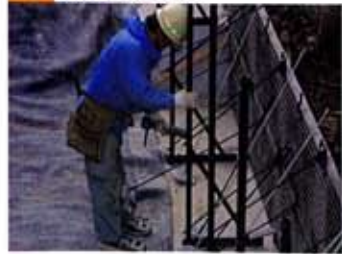
4 組立システムを用いての壁面材設置状況
