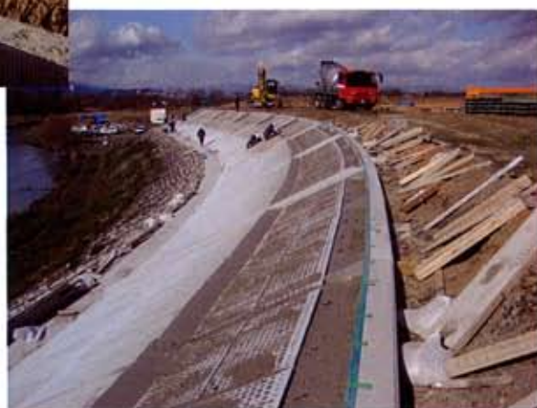
「GPシリーズ施工状況」
