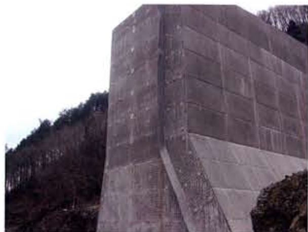
「広島県」 備北地域事務所 太山寺川通常砂防工事 (ピアスタップ) (ワンダータイプ)
