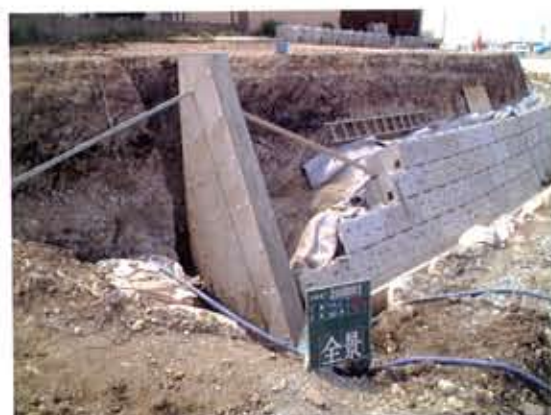
「愛知県」 尾張建設事務所 総合治水対策特定河川工事(小口止め工) (ピアスタ입)
