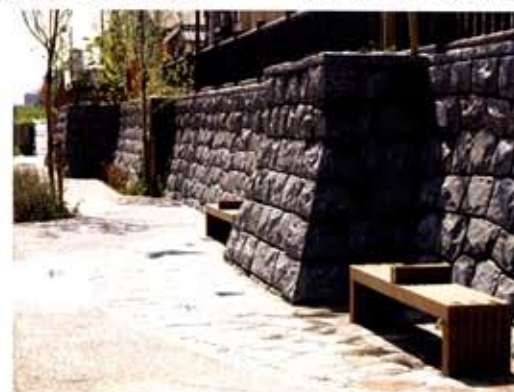
「伸縮目地材が表面に現れない状況」
