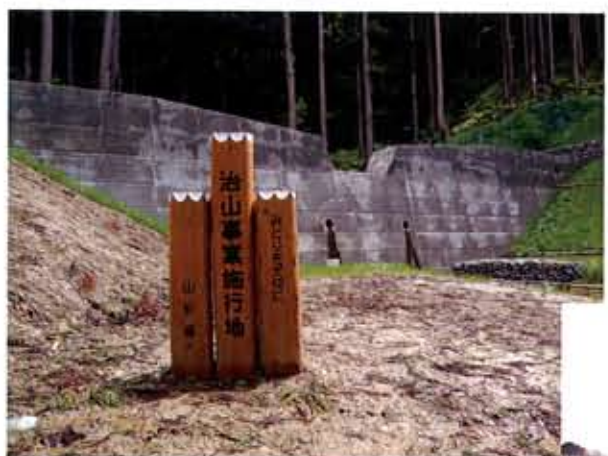
「山形県」 最上総合支庁 十二沢予防治山工事 (ピアスタップ) (ワンダータイプ)
