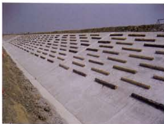
「岐阜県」 中部地方整備局木曾川上流河川事務所 揖斐川割田堤防補強工事 (KISO RIVERS) (KISO RIVERS-GPシリーズ)
