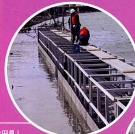
「秋田県」 東北地方整備局秋田河川国道事務所 前野地区環境整備工事(水中コンクリート施工) (ピアスタップ)(ワンダータイプ) (ピアユニットシステム) (ワンダーユニットシステム)
