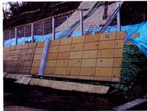
「岩手県」 二戸地方振興局林務部 下尾田地区予防治山工事 (ワンダータイプウッドチップ)
