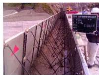
「下流側組立状況」
