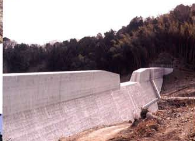
「福岡県」 飯塚土木事務所 大分川3号砂防堰堤工事 (ピアスタップ)
