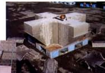
「転用型枠脱型状況」
