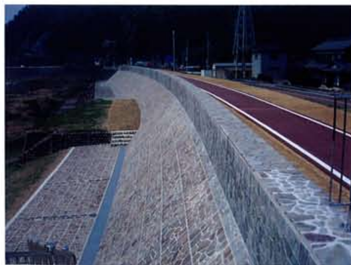
【岐阜県】 中部地方整備局木曾川上流河川事務所 木曾川勝山取組護岸工事 (メーク本石鉄平石張り)
