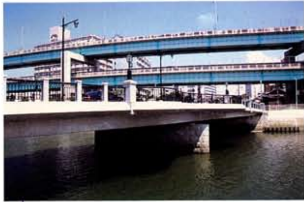
「福岡県」 福岡市役所 西門橋橋台付替工事 (メーク割石40)
