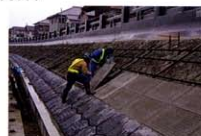
「ピアスユニットシステムを用いた施工状況」
