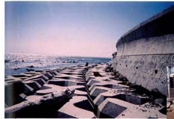
「石川県」 奥能登土木総合事務所 真脇道路災害防除工事 (波返し工) (ピアスタイプ) (メークハツリ面) (メークハツリ面オリジナル波返し)
