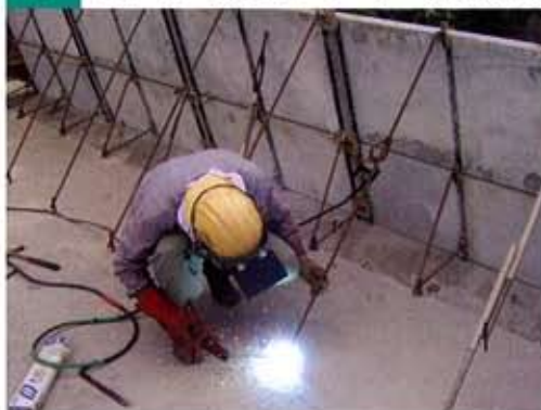
3 専用組立部材取付状況
