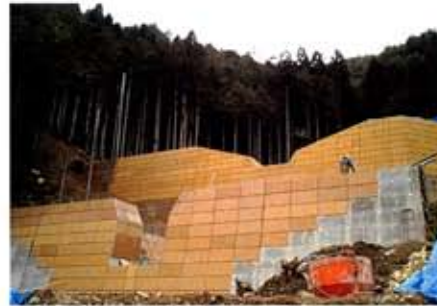
「砂防堰堤施工例」
