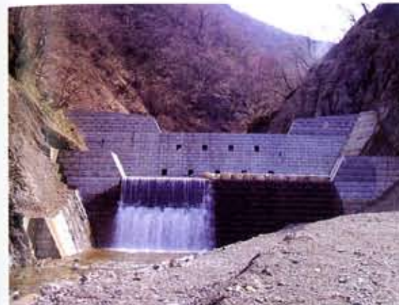
「福井県」 近畿地方整備局福井河川国道事務所 モッカ谷第2堰堤工事 (ピラストタイプ)(メーク割石60)
