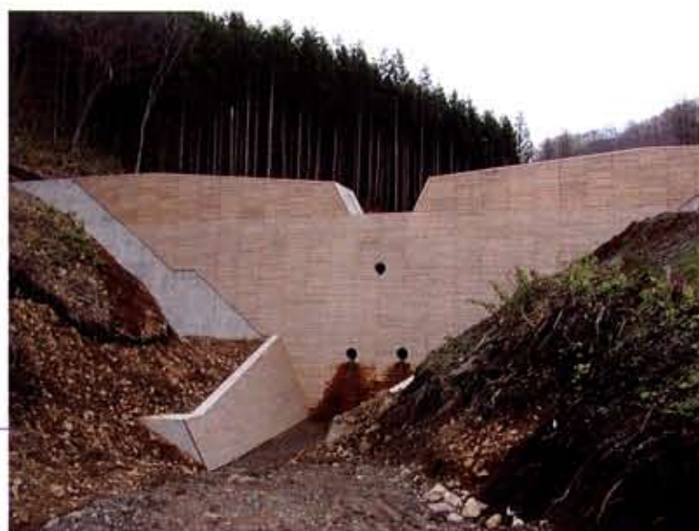
「奈良県」 高田土木事務所 中戸川通常砂防工事 (ピラストタイプ)(メーク割石40)
