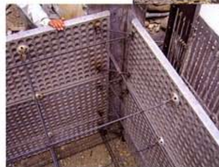
「内部セパレーター取付状況」
