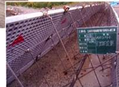
「上流側組立状況」
