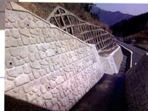
「兵庫県」 山崎土木事務所 429号とりがたわトンネル建設工事 (ピアスタップ) (メーク玉石45)
