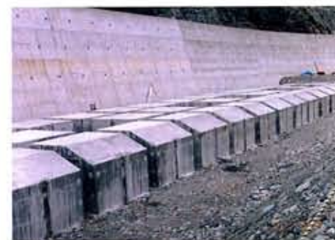
【富山県】 北陸地方整備局立山砂防事務所 真川下流工事用道路工事 (根固め工) (ピアスタイプ)
