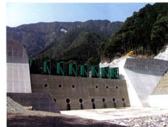
「三重県」 尾鷲建設事務所 赤羽川水系南又谷砂防激基災害対策特別緊急工事 (ピラストタイプ)(ワンダータイプ)
