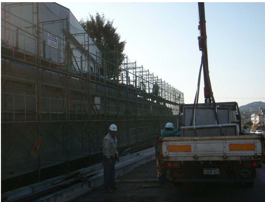
鹿児島市平川施工中006
