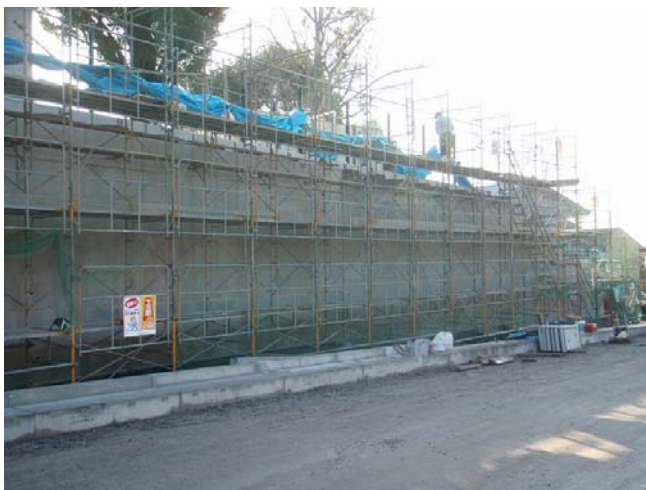
00005鹿児島市平川施工中003. JPG
