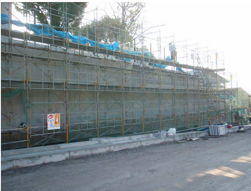
鹿児島市平川施工中003
