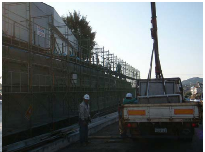
00006鹿児島市平川施工中006. JPG
