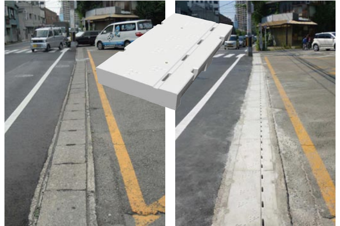
▲施工前 ▲施工後
