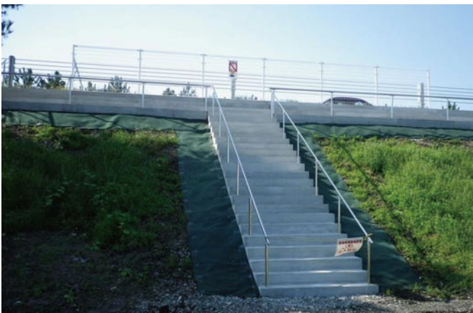
▲仙台東部道路での避難階段としての施工事例
