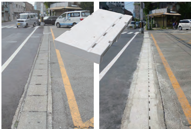
▲施工前 ▲施工後
