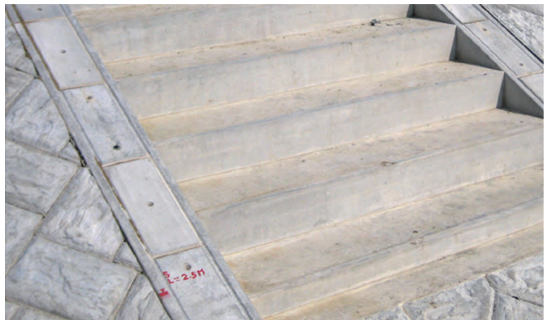
▲階段端部止工
