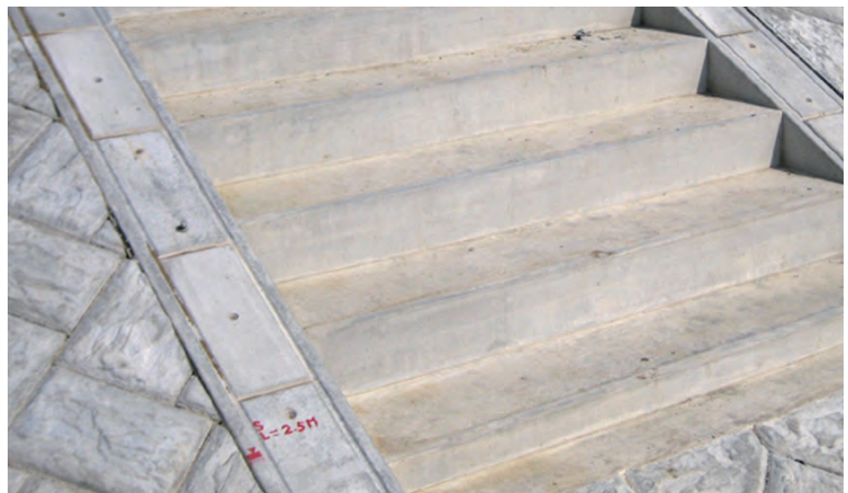
▲階段端部止工
