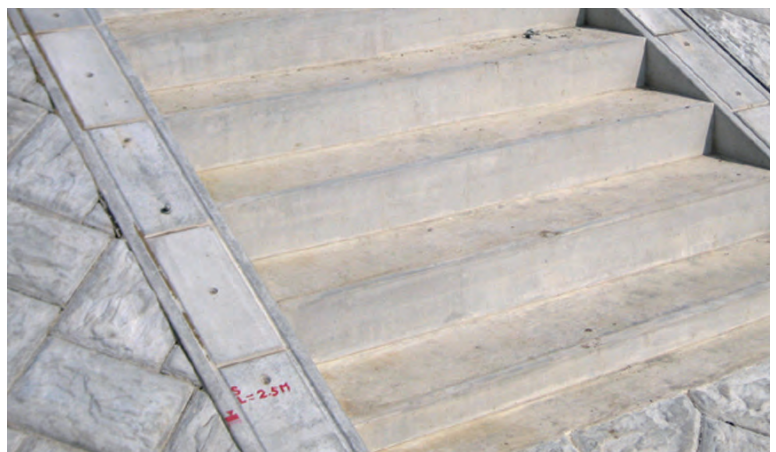
▲階段端部止工
