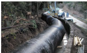
▲上水道管(誘導管)
