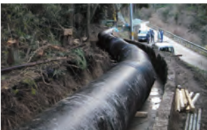
▲上水道管(誘導管)
