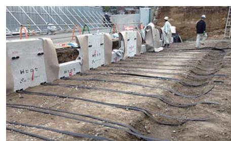
ジオシンセティックス補強材(ストラップ)は、引張強度・摩擦抵抗で従来の鋼製補強材(ストリップ)と同等であり、設計上の耐久性は100年とすぐれた安全性を持っています。また、重量は従来の鋼材の1/10と大幅な軽量化を実現し、施工性の向上が図られました。
