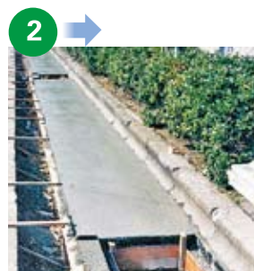
コンクリート打設
