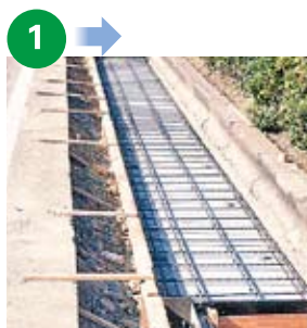
KCフォームの上に配筋した状態
