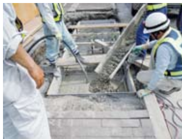
⑤生コン打設。周辺埋戻し。
