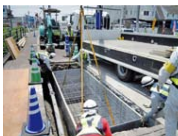
②KCスタンドフォーム据付け
