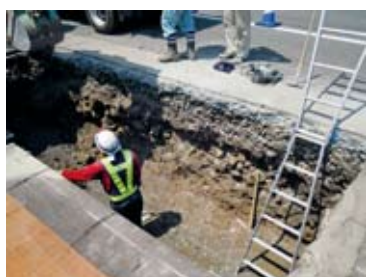
①掘削後敷砂
