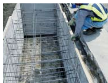
③型枠レベル調整
