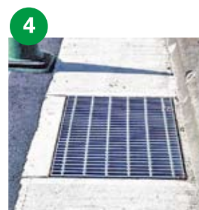
グレーチング設置
