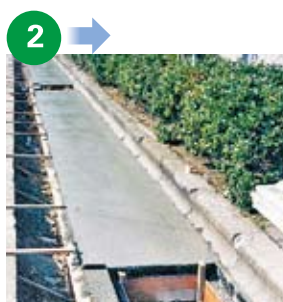
コンクリート打設
