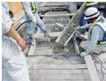
⑤生コン打設。周辺埋戻し。
