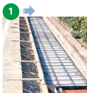
KCフォームの上に配筋した状態
