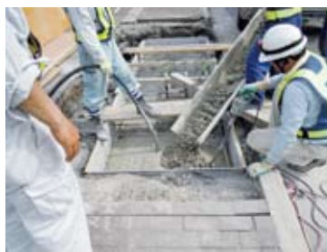
⑤生コン打設。周辺埋戻し。
