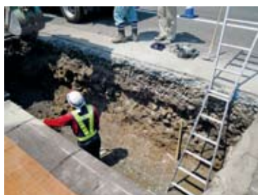
①掘削後敷砂
