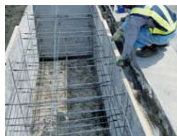
③型枠レベル調整
