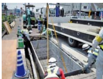
②KCスタンドフォーム据付け
