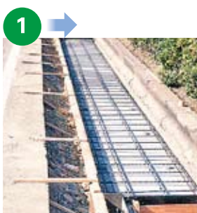
KCフォームの上に配筋した状態
