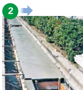
コンクリート打設
