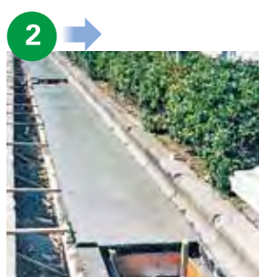
コンクリート打設
