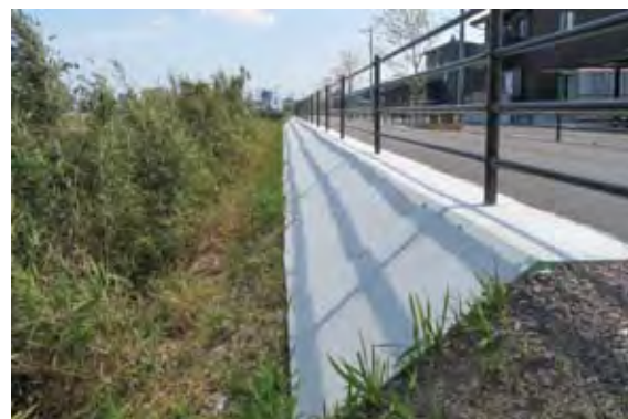
GSボード-ZC施工写真▶
