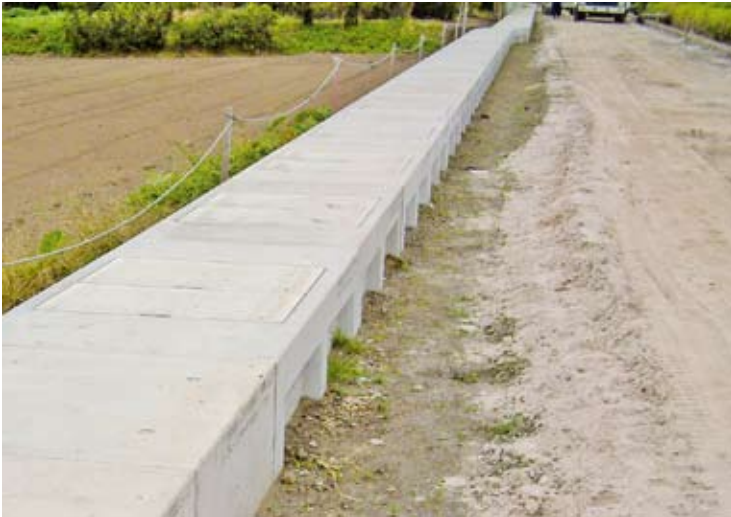
■片土圧による土留工法
