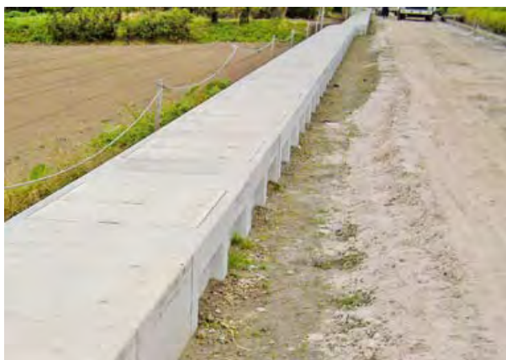
■片土圧による土留工法
