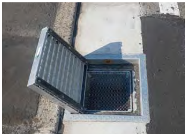
▲PU型300×300A(グレーチング開口状態)
