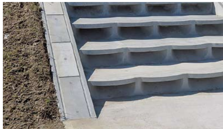
▲階段端部止工
