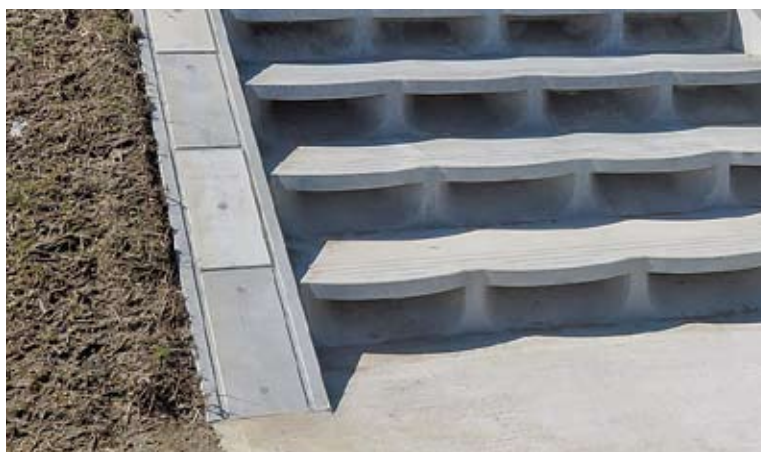
▲階段端部止工
