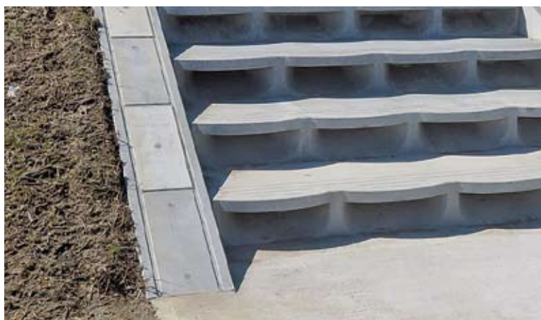
▲階段端部止工
