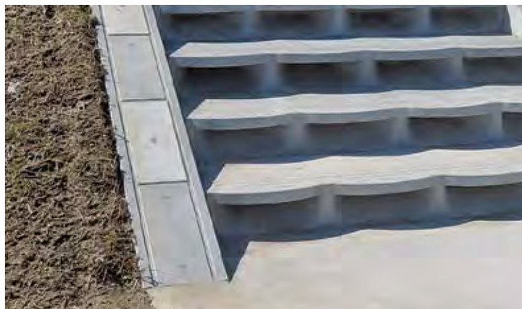
▲階段端部止工
