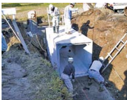
5. 普通型を据付
