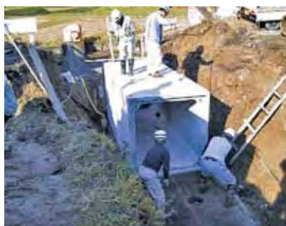
5. 普通型を据付
