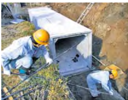
7. PC鋼より線を4穴に通す
