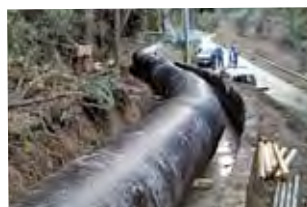
▲上水道管(誘導管)
