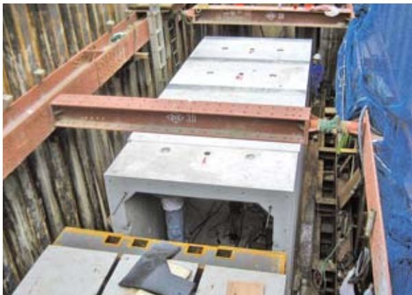
▼アンダーパス非開削施工R&C工法1
