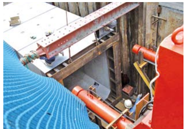
▼アンダーパス非開削施工R&C工法2
