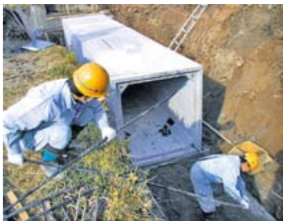
7. PC鋼より線を4穴に通す
