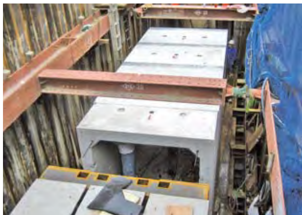
▼アンダーパス非開削施工R&C工法1
