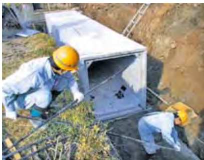
7. PC鋼より線を4穴に通す
