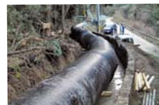
▲上水道管(誘導管)
